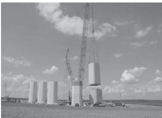
Hình 2.9. Trụ gió tiết diện vuông lắp ghép mảnh ngắ BTCT tiến chế - [55]
