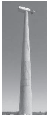
Hình 2.12. Trụ gió BTCT phân đoạn dài công nghệ Acciona (Nam Phi) - [53]
