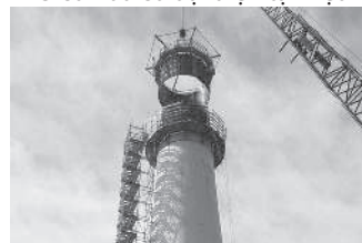
Hình 2.2. Trụ BTCT thi công tại chỗ - [56]
